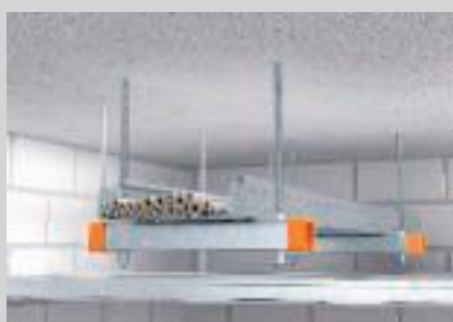
Einlagige Deckenmontage auf Montageschiene.
