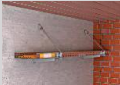
Wandmontage mit Gewindestangensicherung schräg.
