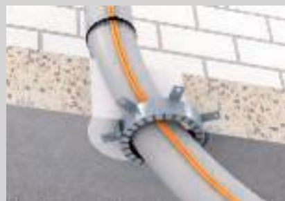
Rohrpostanlagen mit 2 Begleitkabeln.
