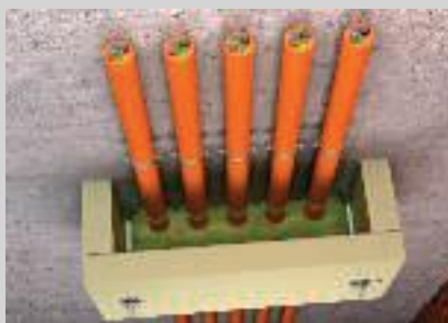
Wirksame Unterstüztungsmaßnahme mit der Zugentlastung ZSE90.
