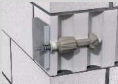
Ankerstange montiert in Kalksandlochstein mit Siebhülse.
