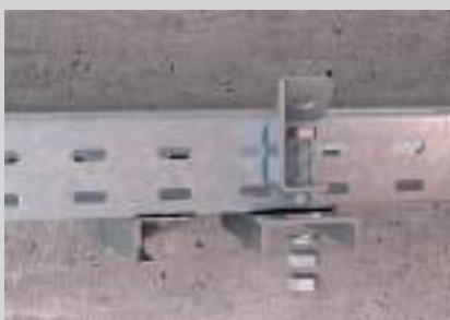
Befestigung des schrägen Anschlussbauteils.
