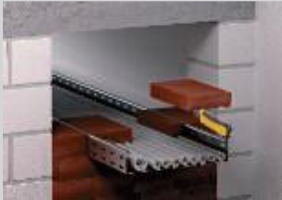
Montage der zugeschnittenen Blöcke.
