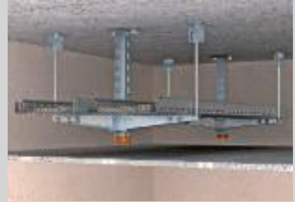
Zweilagige Deckenabhängung mit beidseitiger Auslegeranordnung.
