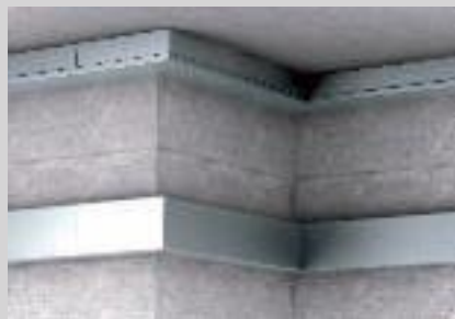
Waagerechte Wand- und Deckenmontage.
