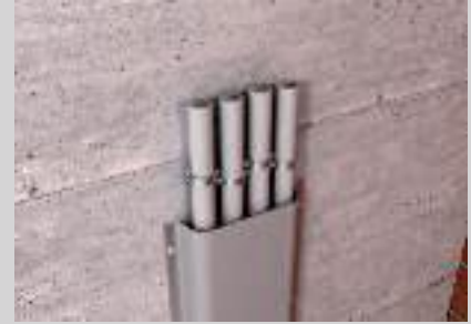
Befestigung der Bandage mit metallischen Schienen bei einer Einzelschelleninstallation.
