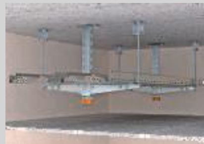
Zweilagige Deckenabhängung mit beidseitiger Auslegeranordnung.
