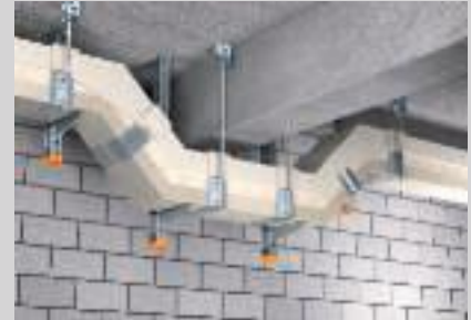
Vorgefertigte Formteile für Richtungsänderungen bei abgehängter Montage.
