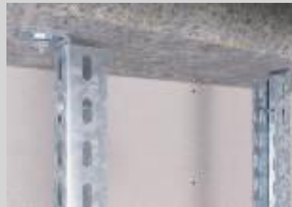
Deckenbefestigung der Leiterholme mit angeschraubten Montagewinkeln.
