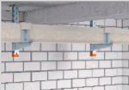
Abgehängte Deckenmontage als I-Kanal.
