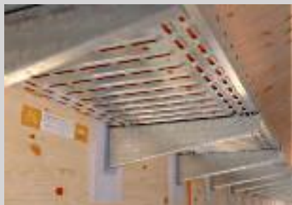
Auslegermontage seitlich am Holzbalken mit hinterlegter Brandschutzplatte.
