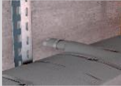
Kabelausgang mit Bandagierung.
