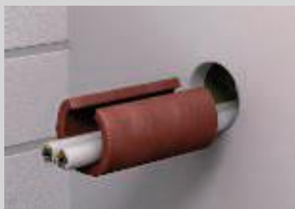
Bei bereits installierten Kabeln Aufschneiden der Rohrschale.
