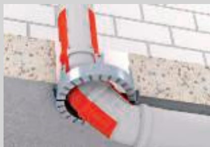
Rohrmuffen im Bereich der Durchführung.
