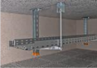
Einlagige Deckenabhängung mit Hängestiel und Ausleger.
