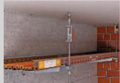
Deckenbefestigung der Gewindestangen mit Brandschutzbügel.
