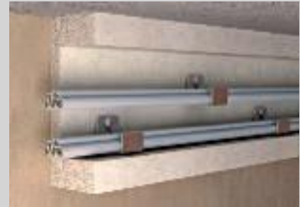
Haltewinkel und Haltebügel als Montagehilfe für das Einlegen der Kabel.
