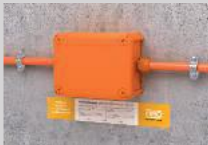
Fertig installierte FireBox mit Kennzeichnungsschild.
