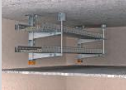
Zweilagige Deckenabhängung mit einseitiger Auslegeranordnung.
