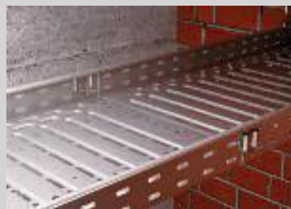
Stoßstellenverbindung ohne zusätzliche Verschraubung.
