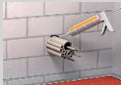
Verschließen der Ringspalte mit Dämmschichtbildner DSX.
