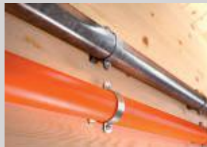
Kabelverlegung mit Einzelschellen und im Rohre seitlich am Holzbalken.
