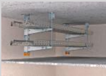
Zweilagige Deckenabhängung mit einseitiger Auslegeranordnung.
