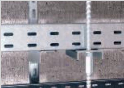
Gewindestangenbefestigung an der Kabelrinne bei mehrlagiger Anordnung.
