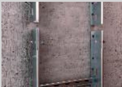
Stoßstellenverbindung mit verschraubtem Verbinder.
