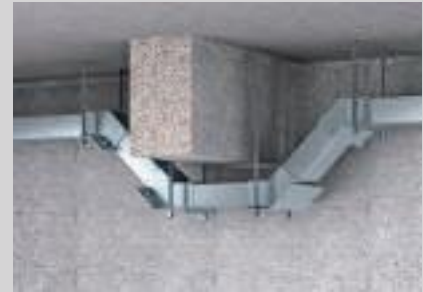
Abgehängte Montage mit Vertikalbögen.
