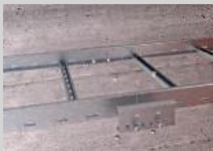
Montage der Längsverbinder mit Flachrundschauben.
