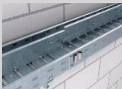
Trennstegmontage mit Flachrundschraven.
