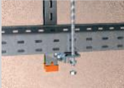
Montage der Gewindestangensicherung durch Anschlusswinkel an der Auslegerspitze.
