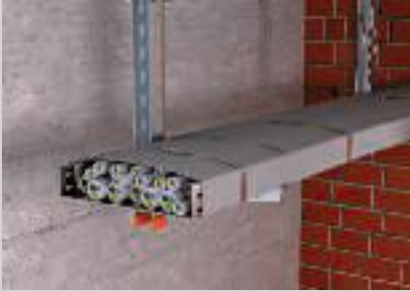
Komplette Umhüllung einer abgehängten Kabeltrasse.
