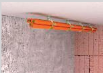
Gebündelte Kabelverlegung unter der Decke.
