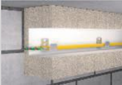
Haltenwinkel als Montagehilfe für das Einlegen der Lichtwellenleiter-Kabel (LWL).
