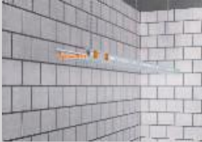
Einlagige Deckenmontage der Kabelrinne mit einer Mittenabhängung.
