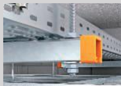
Anschluss der Gewindestange an der Montageschiene.
