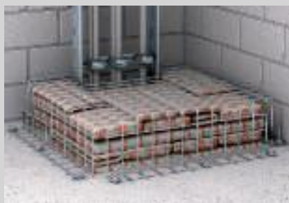
Sicherung gegen Abrutschen oberhalb des Fußbodens.
