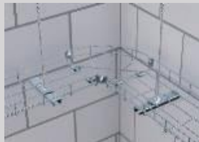
Formteilmontage mit Stoßstellenverbinder.
