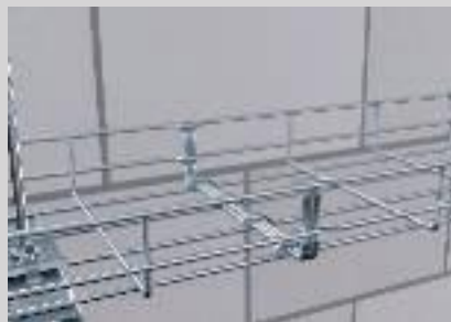
Fertige schraubenlose Stoßstellenverbindung.
