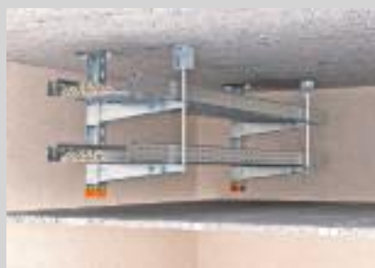
Zweilagige Deckenabhängung mit einseitiger Auslegeranordnung.
