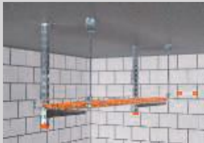
Deckenmontage mit einseitig montiertem Ausleger.
