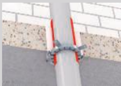
Montage an der Deckenunterseite mit Metalldübeln.
