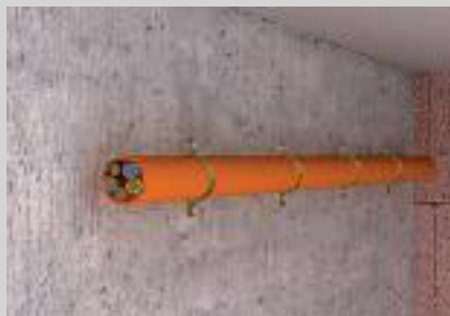
Waagerechte Montage der Kabel an der Wand.
