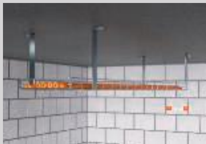
Einlagige Deckenmontage mit Abhängebügel.
