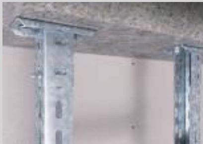
Deckenbefestigung der Leiterholme mit angeschraubten Kopfplatten.
