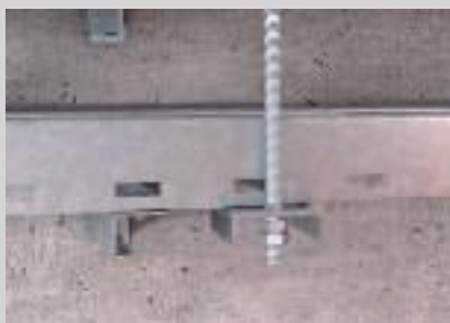
Befestigung der senkrechten Gewindestange am Anschlussbauteil.
