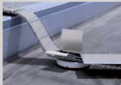
Einsatz bei über Brandwand geführten Photovoltaikleitungen.
