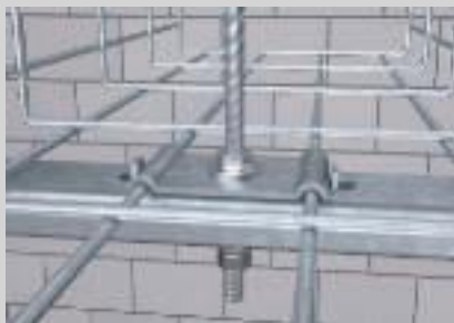
Positionierung und Befestigung des Klemmstücks mit der Gewindestange.
