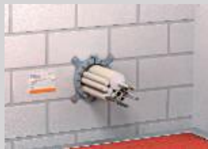
Gekennzeichnete Abschottung von Installationsrohrbündeln.
