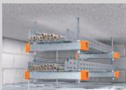
Zweilagige Deckenmontage auf Montageschienen.
