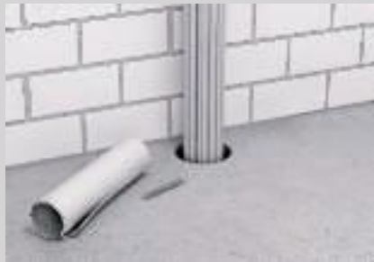
Vorbereitung der Kabelabschottung.
