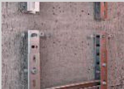
Stoßstellenausführung mit verschraubtem Verbinder.
