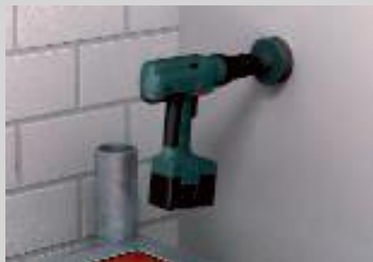
Bohren eines Lochs mit einem Dosenbohrer.
