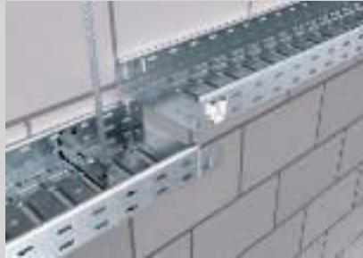
Erstellen der Längsverbinding durch Ineinanderstecken der Kabelrinnen.
