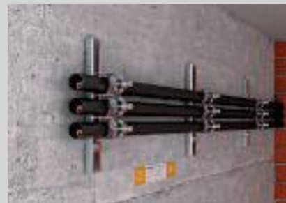
Platzsparende Installation mehrerer Rohre nebeneinander mit Bügelschellen.
