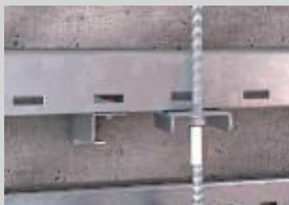
Gewindestangenbefestigung an der Kabelleiter bei mehrlagiger Anordnung.
