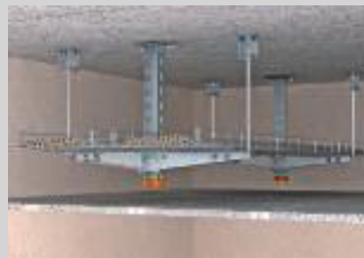
Zweilagige Deckenabhängung mit beidseitiger Auslegeranordnung.
