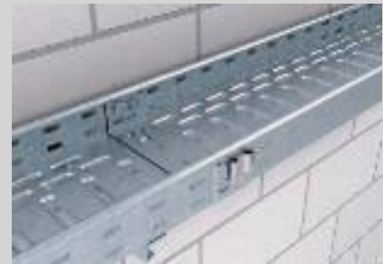
Fertige schraubenlose Stoßstellenverbinding.
