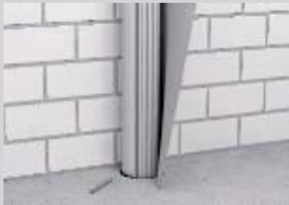
Installation der Brandschutzbandage.
