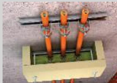
Wirksame Unterstützungsmaßnahme mit der Zugentlastung ZSE90.
