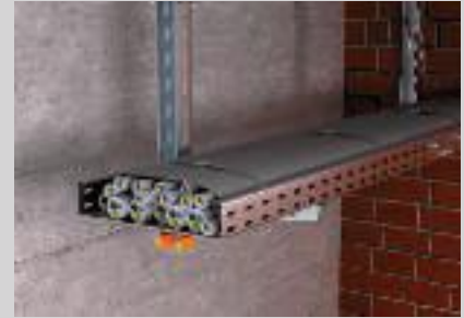
Bandagierung der Kabelbündel auf Tragsystemen.
