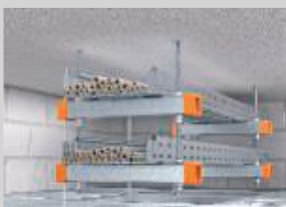
Zweilagige Deckenmontage auf Montageschienen.
