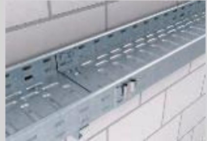
Fertige schraubenlose Stoßstellenverbindung.
