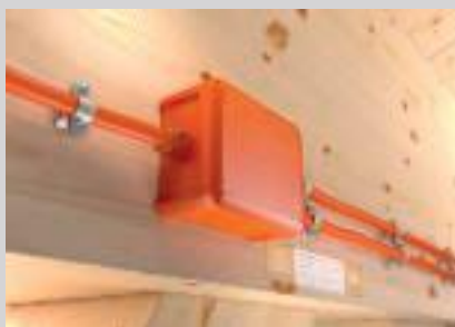
Montage der OBO FireBox am Holzbalken.
