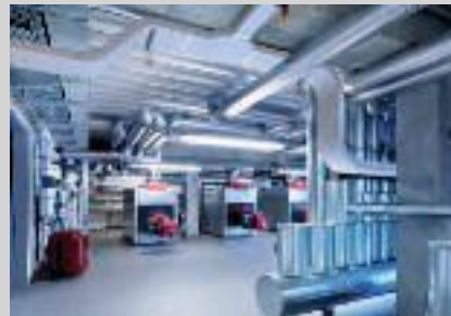
Anwendung auf Tragsystemen in Versorgungsräumen oder Produktionshallen.
