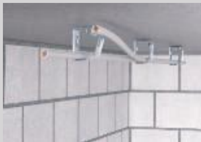
Öffnen der Sammelhalterung und Einlegen der Kabel.
