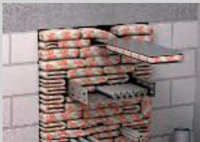
Bleche als Montagehilfe für die letzte Kissenlage.
