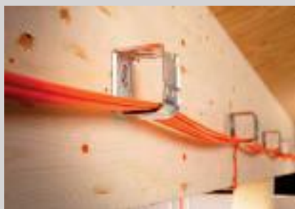
Kabelverlegung mit Sammelhalterung seitlich am Holzbalken.
