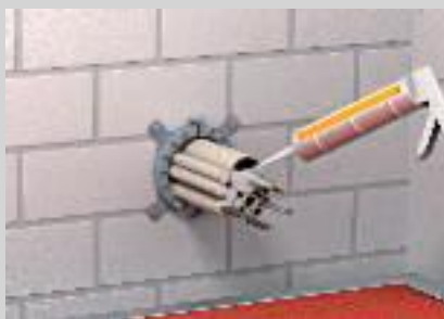
Verschließen der Rohrenden mit Dämmschichtbildner DSX.
