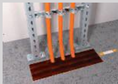
Verschluss der Deckenöffnung mit einem zugelassenen Abschottungssystem.
