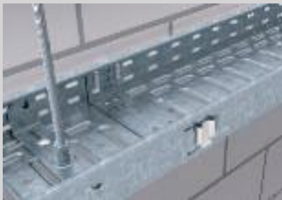
Fertige schraubenlose Stoßstellenverbindung.
