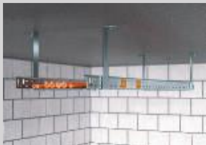
Einlagige Deckenmontage mit Abhängebügel.
