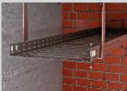
Befestigung der Kabelrinne mit Flachrundschräuben.
