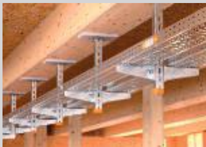
Hängestielmontage unter dem Holzbalken mit hinterlegter Brandschutzplatte.
