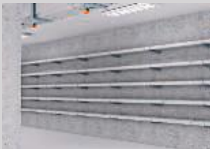
Kabeltunnel mit Bandagen in Kraftwerken.
