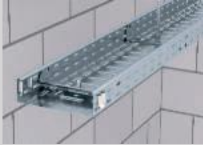
Einsetzen der Mittenabhängung in die Kabelrinne.
