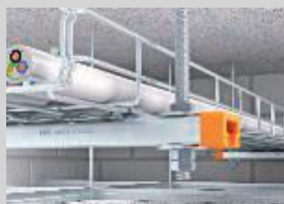
Anschluss der Gewindestange an der Montagesschiene.
