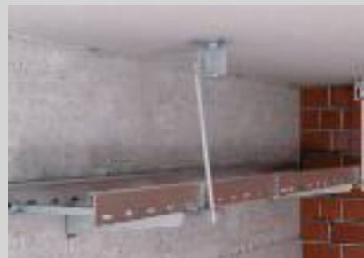
Deckenbefestigung der Gewindestangen mit Brandschutzbügel.
