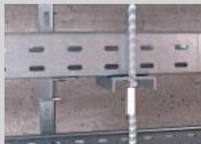
Gewindestangenbefestigung an der Rinne bei mehrlagiger Anordnung.
