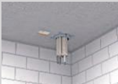
Montage an der Deckenunterseite mit Metalldübeln.
