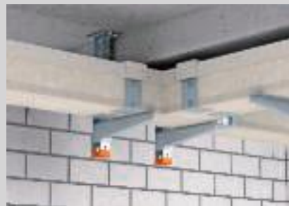
Vormontierte Standardformteile im Trassenverlauf.
