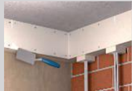
Kleine Beschädigungen können jederzeit beseitigt werden.
