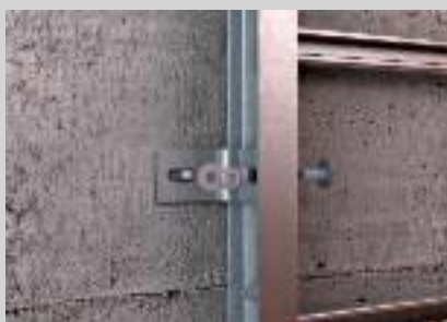
Montage mit verschraubten Befestigungswinkeln.
