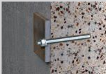
Ankerstange montiert in Beton ohne Siebhülse.
