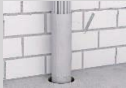
Fixieren der Bandage mittels Wickeldraht.
