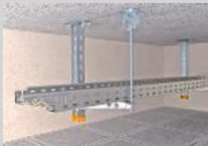
Einlagige Deckenabhängung mit Hängestiel und Ausleger.
