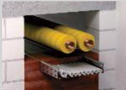
Durchgeführte nicht brennbare Rohre mit Streckenisolierung.
