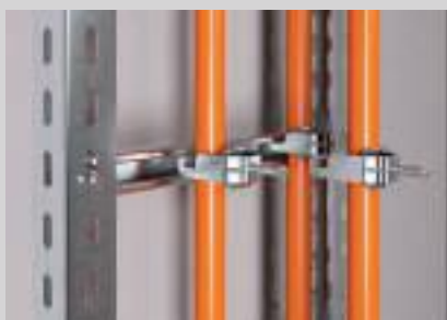
Kabelinstallation mit Bügelschellen 2056 UM an den Sprossen der Steigeleiter.
