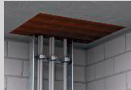
Strammsitzender Einbau der Blöcke im Deckendurchbruch.
