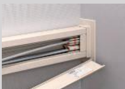
Unauffällige Anbringung des Kennzeichnungsschildes.
