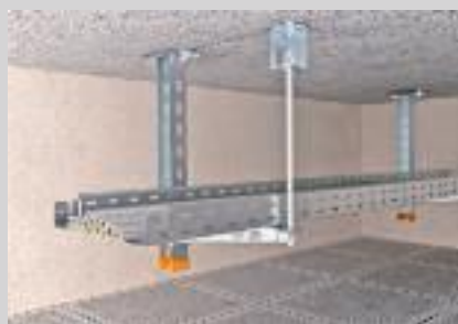
Einlagige Deckenabhängung mit Hängestiel und Ausleger.
