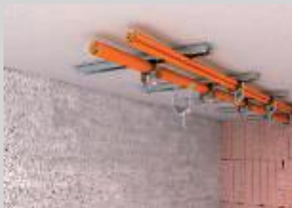
Installation der Kabel einzeln oder als Bündel.
