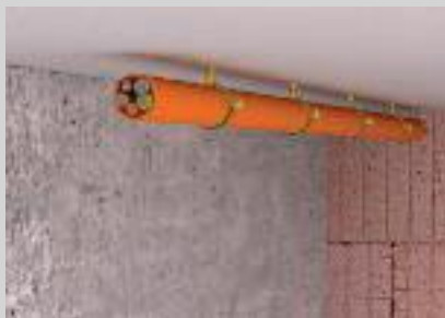
Montage unter der Decke.
