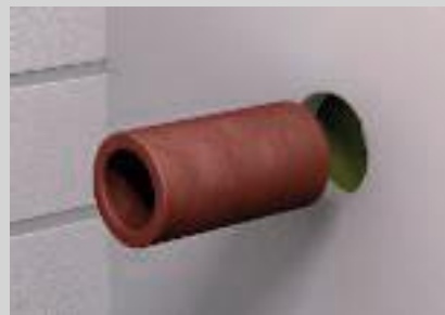
Einsetzen der Rohrschale in die leichte Trennwand.
