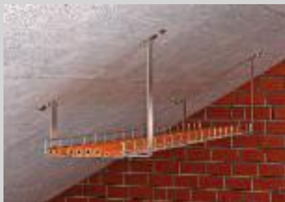
Montage unter schräger Decke mit individuell angepasstem Abhängebügel.
