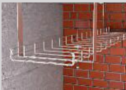
Befestigung der Gitterrinne mit Klemmstück und Flachrundschrauben.
