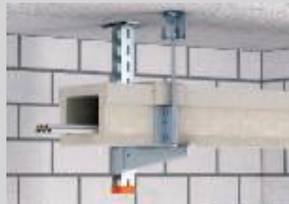
Montage als E-Kanal mit zusätzlicher Gewindestangensicherung.
