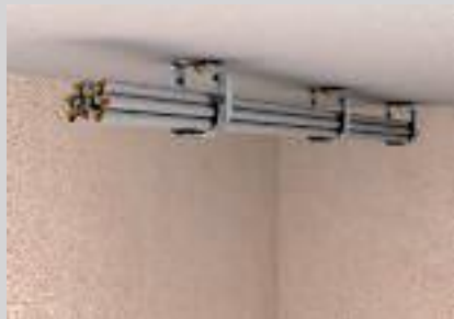
Deckenmontage der Sammelhalterungen 2031 M15 und 2031 M 30.
