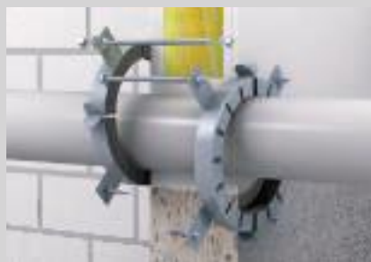
Exzentrische Anordnung mit max. 3 Stufen größeren Rohrmanschetten.
