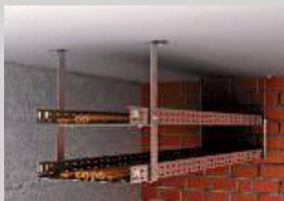
Zweilagige Deckenmontage mit Abhängebügel und Verlängerung.
