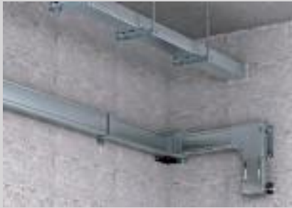
Direkte Wand- und Deckenmontage.
