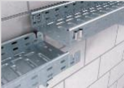
Erstellen der Längsverbinding durch Ineinanderstecken der Kabelrinnen.
