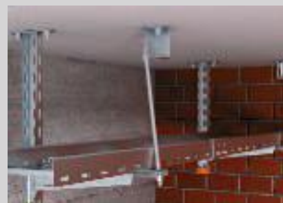
Einhängen der Gewindestange in den Brandschutzbügel.
