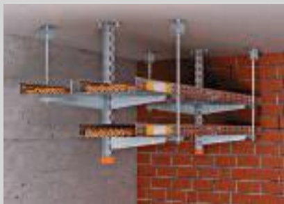
Deckenabhängung mit beidseitiger Anordnung der Ausleger.
