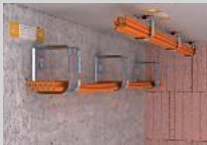
Waagerechte Wand- und Deckenmontage.
