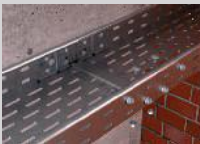
Längsverbinder und Stoßstellenleiste mit Flachrundschrauben befestigen.
