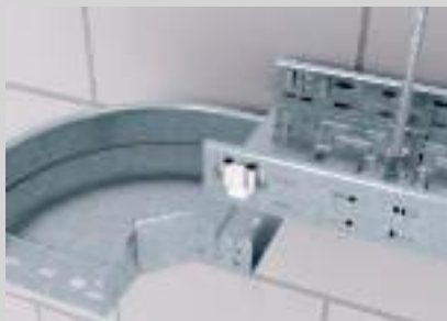
Schnelle und einfache Formteilmontage mit schraubenloser Magic-Verbindung.
