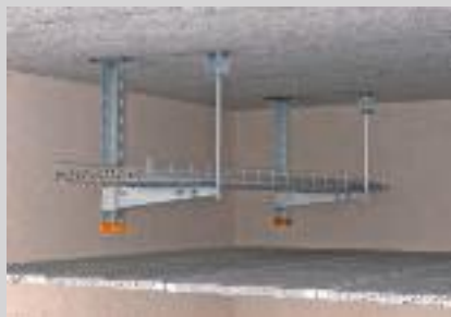
Einlagige Deckenabhängung mit Hängestiel und Ausleger.
