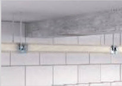
Abgehängte Montage an den Verbinder-elementen.
