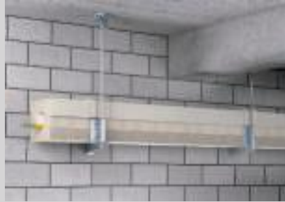
Wandmontage auf Auslgern und zusätzlicher Gewindestangesicherung.
