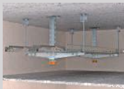
Zweilagige Deckenabhängung mit beidseitiger Auslegeranordnung.
