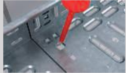
Umbiegen der Sicherungslaschen im Boden.
