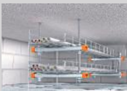
Zweilagige Deckenmontage auf Montagesschienen.
